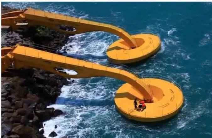
**Figura 2 - Implantação de Protótipo de Conversor de Ondas Onshore nas Condições de Mar do Nordeste do Brasil.**
