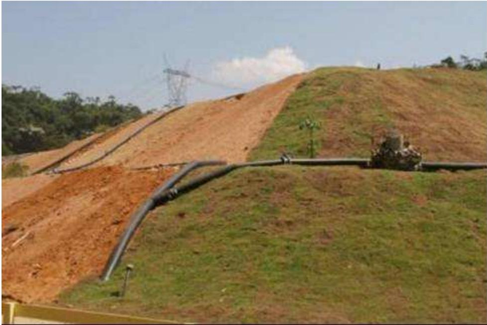
Figura 1 Exemplo de sistema de coleta de gás de aterro. A imagem acima refere-se ao sistema implementado na CTR Nova Iguaçu, operado pela Haztec Tecnologia e Planejamento Ambiental S.A. (HAZTEC).
