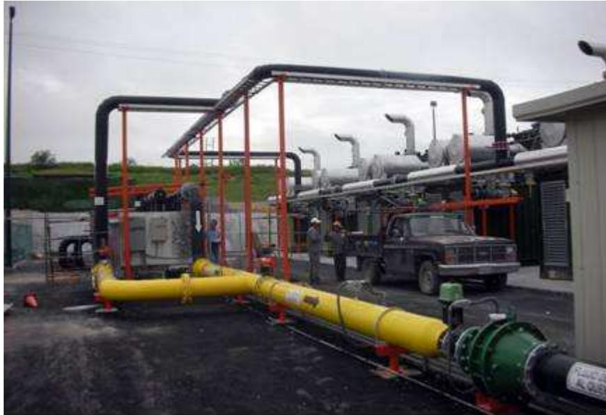
**Figura 4** Exemplo de instalação modular de geração de eletricidade que será implementada neste projeto. A imagem acima foi registrada no Aterro de Monterrey, México.
