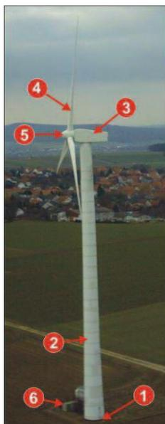
1. Fundação: ancora a turbina no solo e assegura sua estabilidade. Em geral, é feita de concreto ou aço.
