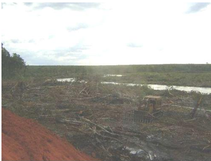
Figura 4 – Limpeza da área do reservatório
