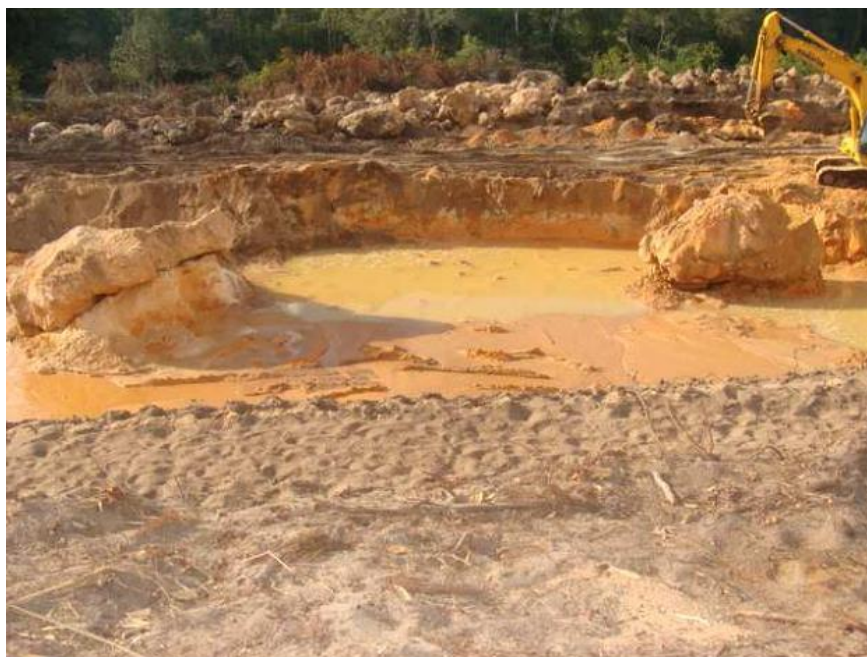
Figura 3 – Escavações para a casa de força
