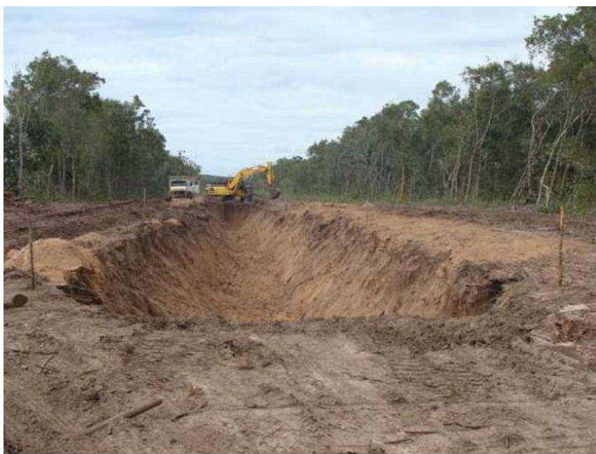
Figura 2 – Escavações do canal de adução
