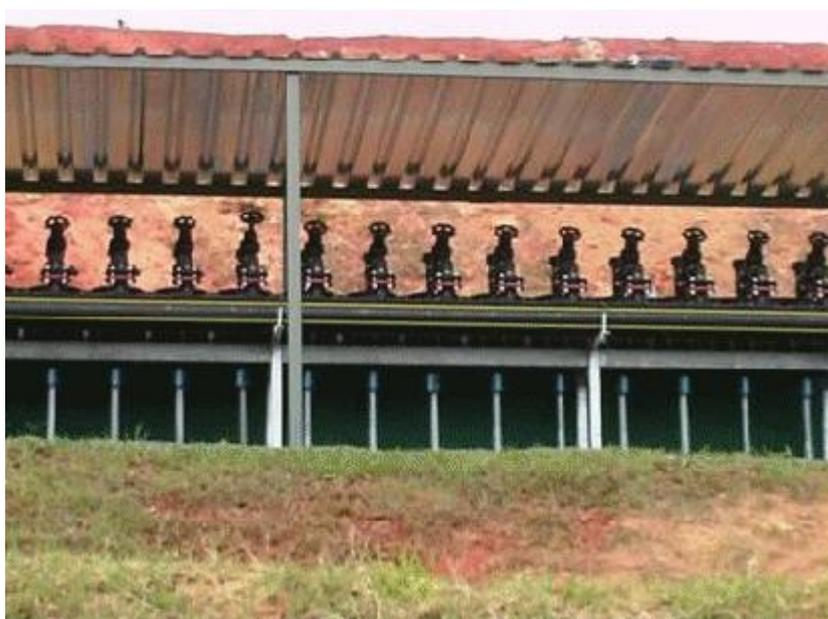
**Figura 3 – Exemplo de sistema de coleta (manifolds)**
