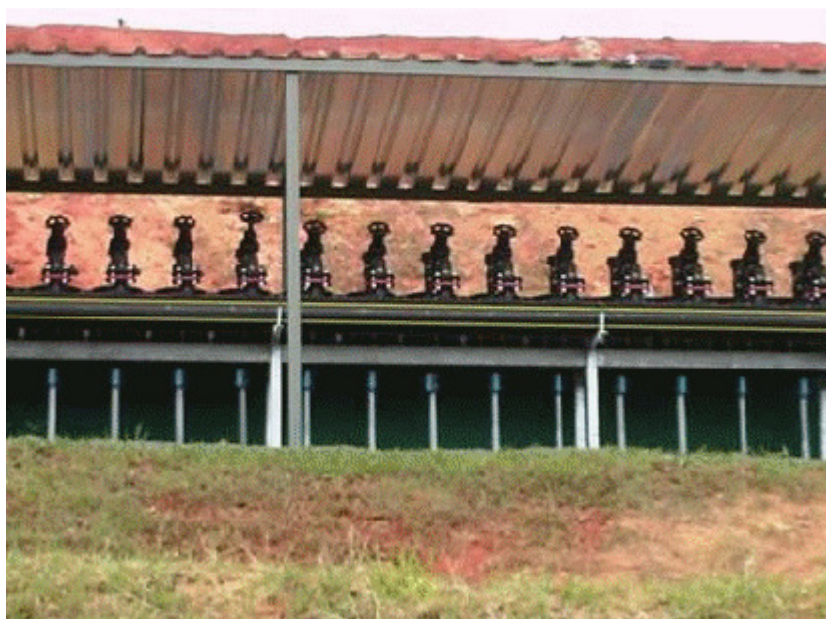
Figura 2 – Exemplo de sistema de controle (manifolds)
