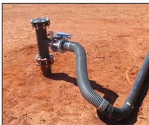
Figura 4 - Exemplo de cabeça de poço
