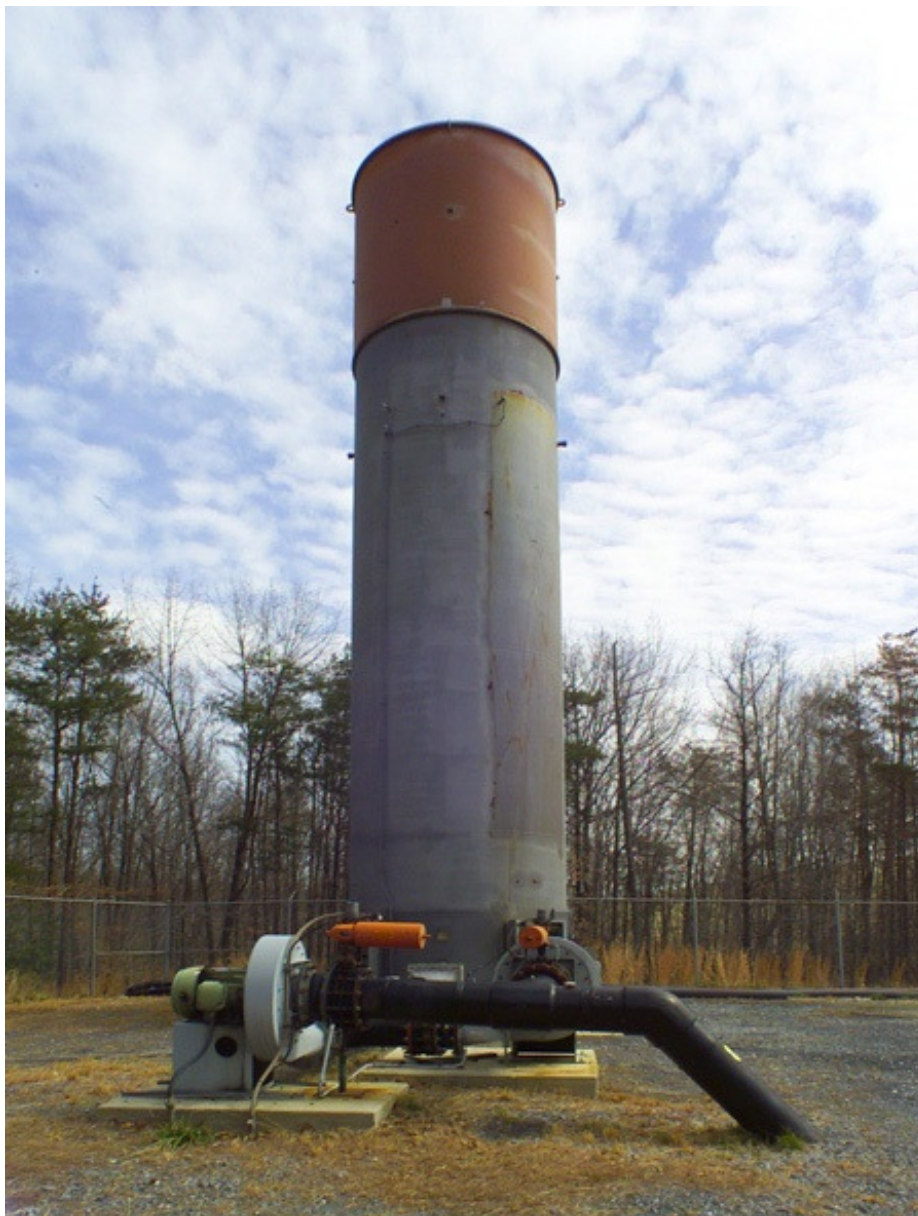
Figura 7 - Detalhe de um flare fechado
