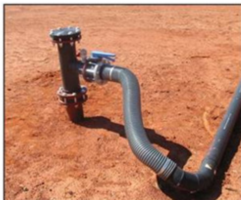
Figura 4 - Exemplo de cabeça de poço
