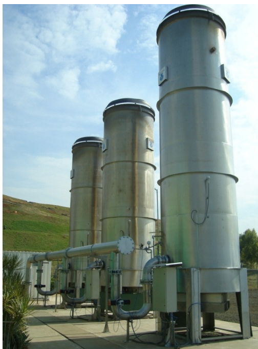
Figura 7 - Detalhe de um flare fechado Fonte: ESTRE Ambiental S.A.
