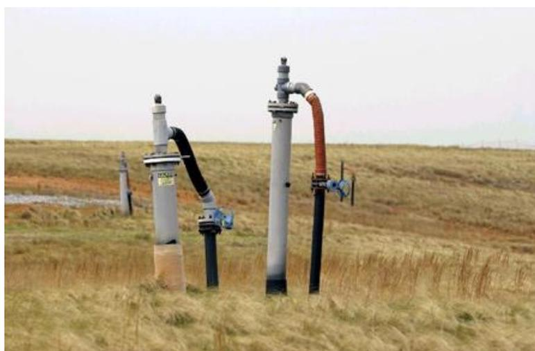
**Figura 4 - Exemplo de sistema de coleta (cabeçote)**
