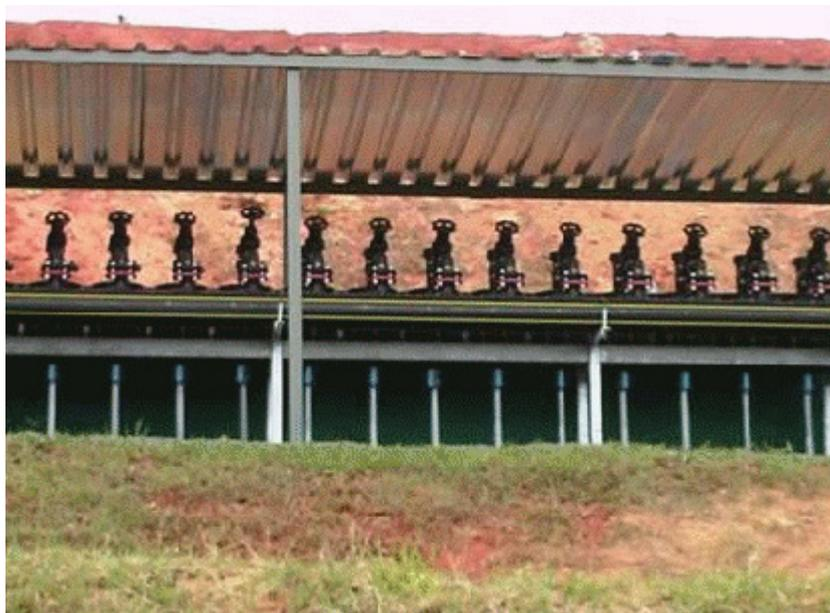
**Figura 2 – Exemplo de sistema de controle (manifolds)**
