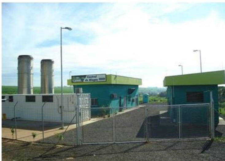
**Figura 7 - Exemplo de um sistema de flare**
