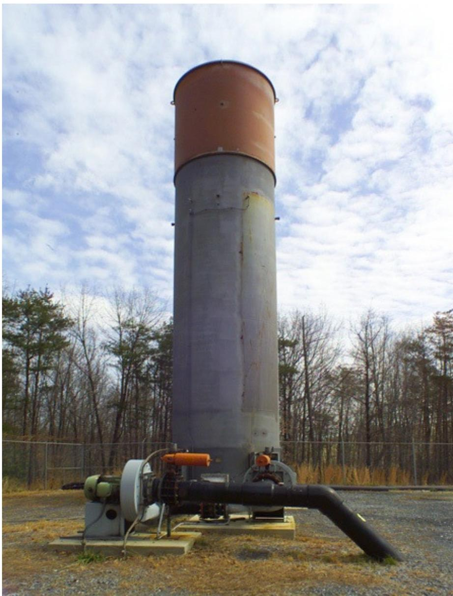
**Figura 6 - Detalhe de um flare fechado**
