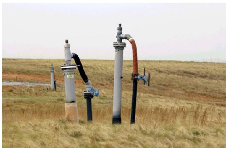
**Figura 3 - Exemplo de sistema de coleta (cabeçote)**
