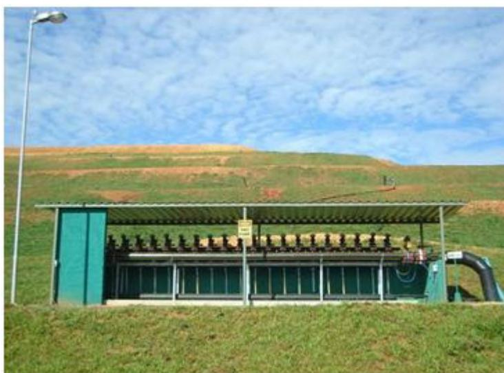
**Figura 3 – Exemplo de estação de controle (manifolds)**
