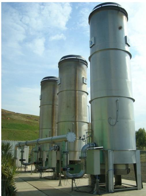
**Figura 7 - Detalhe de um flare fechado**
