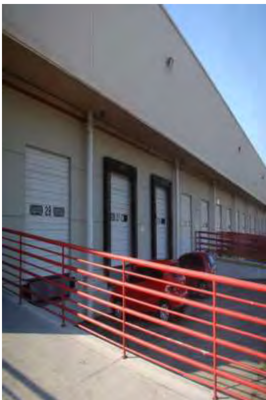
Rampa de acesso à casa de máquinas do CEMADEN
