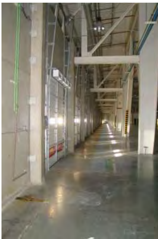
Corredor entre acesso das boias e inicio de nossas instalações
