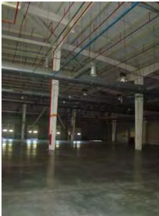
Vista da porta de enrolar (Futuro acesso a casa de máquinas)
