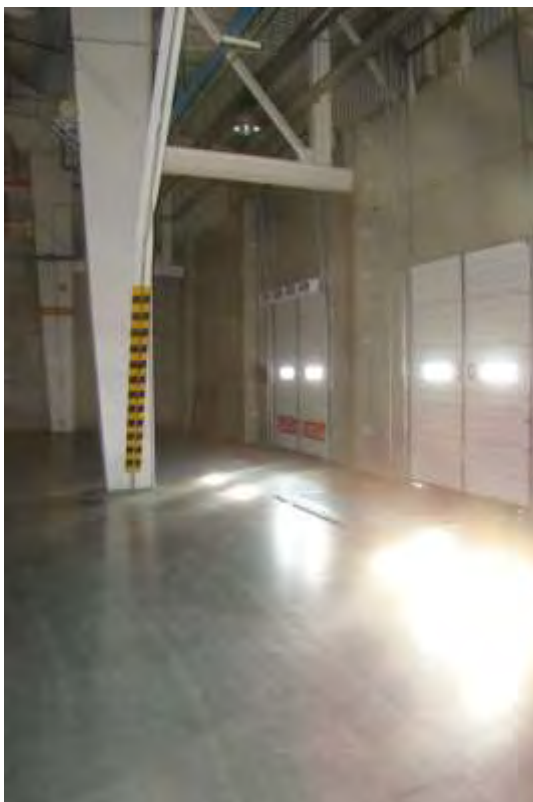
Área do futuro almoxarifado/depósito face Norte
