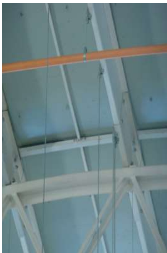
Mais detalhes de tirantes e fixação em estrutura.
