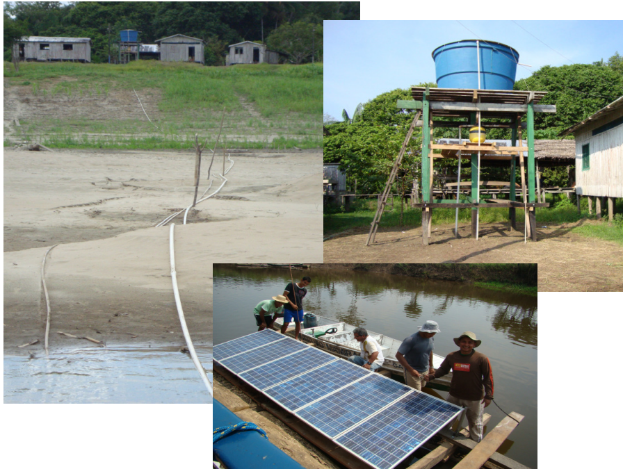
Figura 1: Ilustração de um sistema comunitário de captação e bombeamento de água movido a energia solar.
