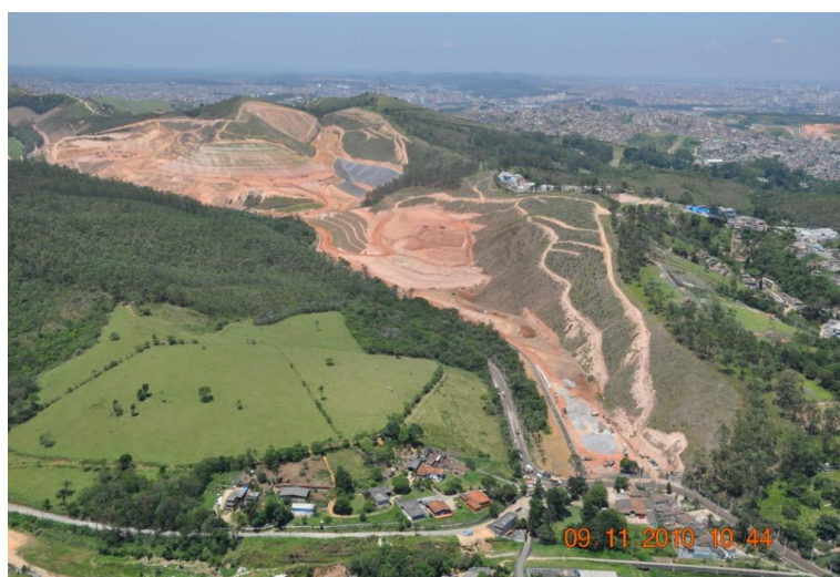
Figura 2 - Vista aérea do Aterro Sanitário CTL durante a fase de operação e antes do início da fase de recebimento de resíduos.
