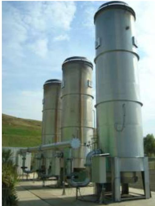
**Figura 7 – Detalhe de Queimador fechado**
