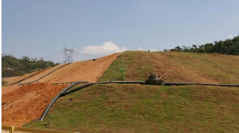
Sob a atividade do projeto, poços verticais serão cavados (entre 10-30 metros de profundidade), usando tubulação HDPE para extrair o gás. Cada poço terá uma boca de carga individual, incorporando um aparelho de medição de fluxo de LFG embutido, porta de temperatura do gás, portas de conexão rápida de amostras de gás e uma válvula de controle de fluxo para monitorar a quantidade e qualidade do LFG coletado.
