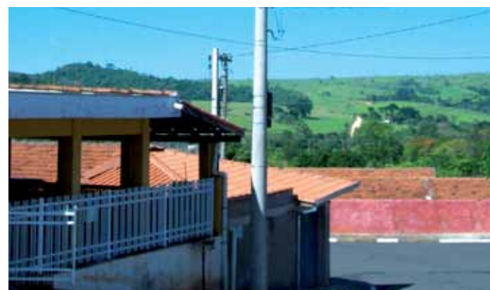
O cabeamento tem doze km de extensão
