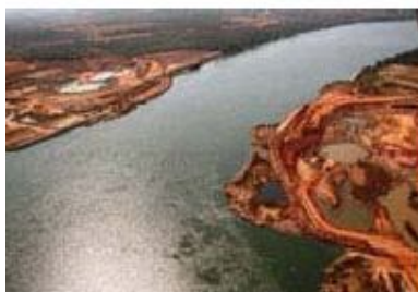
Escavações e desvio do rio
