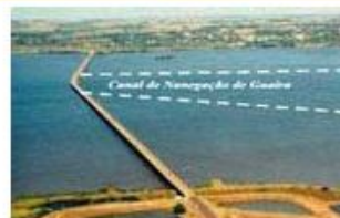
Localização do derrocamento no rio Paraná
