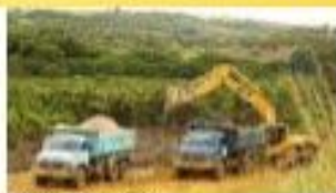
Serviço de terraplenagem
