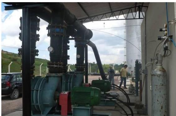
Figura 6 - Sistema de sopragem
