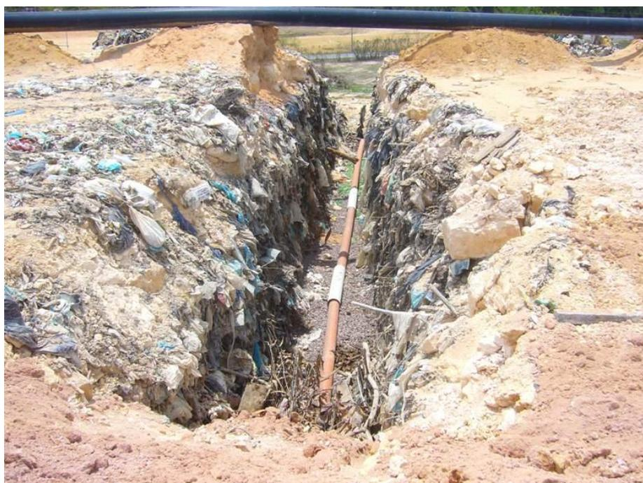
**Figura 3 - Exemplo do sistema de coleta horizontal (trincheiras)**
