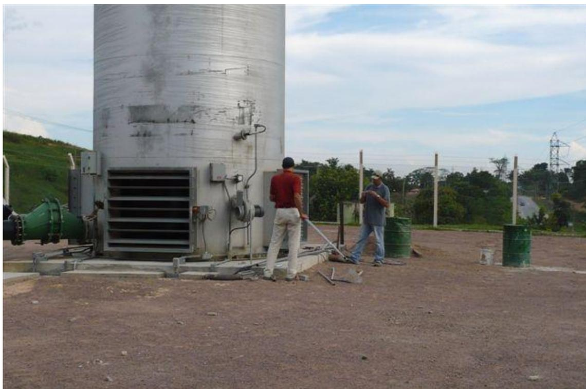
Figura 8 - Detalhe de um flare enclausurado
