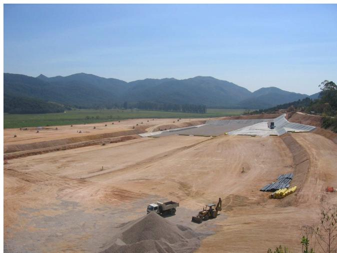
**Figura 5: Instalação da geomembrana em cima da zona 1**
