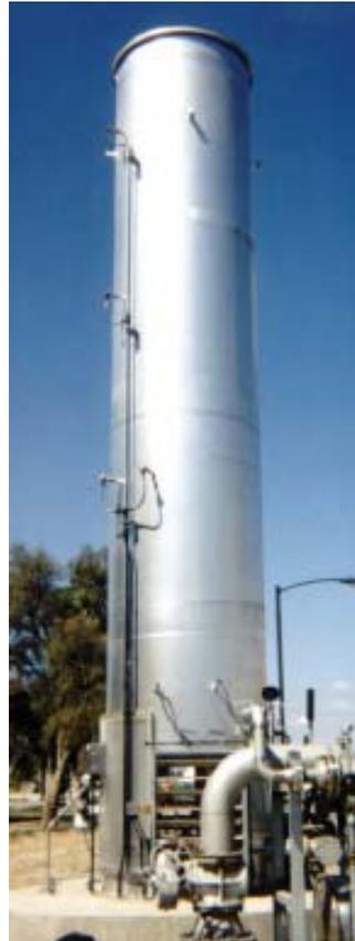
Figura 13. Flare Enclausurado instalado (Fonte: John Zink, Acesso em 31 Janeiro 2006)
