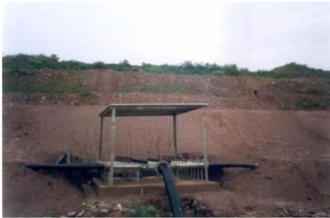
Figura 7. Exemplo de manifold conectado à linha de transmissão
