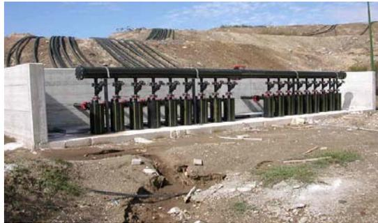
Figura 8. Exemplo de Estação de Regulagem de Gás
