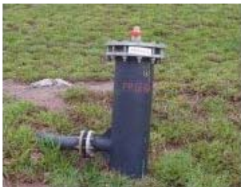
Figura 3. Exemplo de um cabeçote de dreno (Fonte: Biogás Ambiental 4 )
