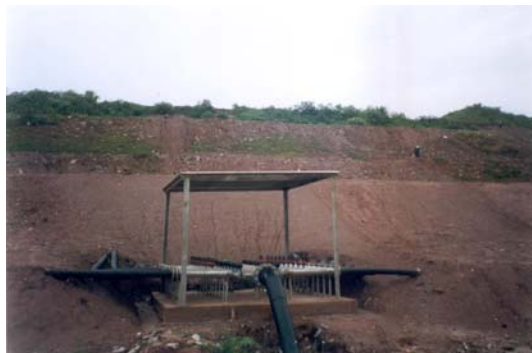
Figura 5. Exemplo de um manifold, conectado à tubulação de transporte
