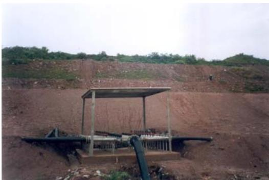
Figura 6. Exemplo de um *manifold*, conectado à tubulação de transporte
