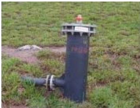
Figura 4. Exemplo de um cabeçote de dreno (Fonte: Biogás Ambiental<sup>3</sup>)
