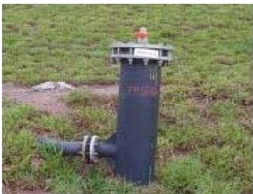
**Figura 3. Exemplo de um cabeçote de dreno (Fonte: Biogás Ambiental<sup>4</sup>)**
