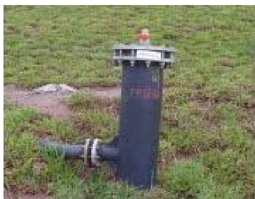
Figura 3. Exemplo de um cabeçote de dreno (Fonte: Biogás Ambiental 5 )
