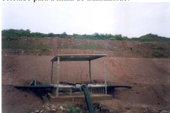
Figura 5. Exemplo de um manifold, conectado à linha de transmissão
