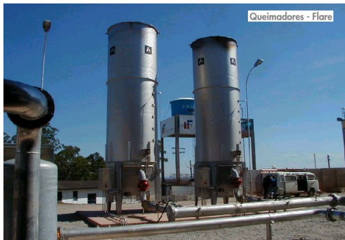
Figura 7. Exemplo de flares (fonte: Biogás Ambiental)
