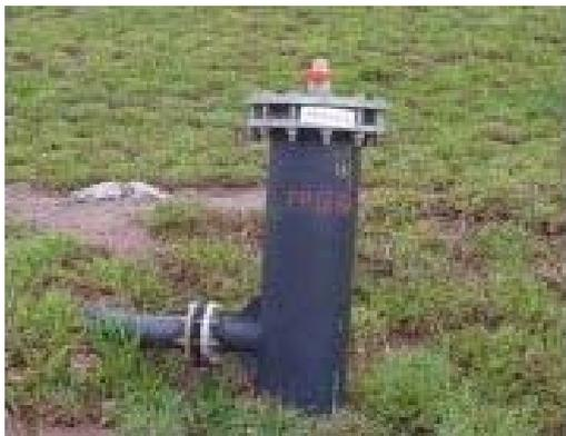
Figura 3. Exemplo de um cabeçote de dreno
