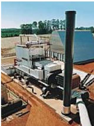
**Figura 1: Exemplo de caldeira aquatubular fabricada pela Biochamm, indústria brasileira. O mesmo tipo será utilizado pelo Projeto Imbituva.**
