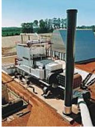
**Figura 1: Exemplo de caldeira aquatubular fabricada pela Biochamm, indústria brasileira. O mesmo tipo será utilizado pelo Projeto Inácio Martins.**
