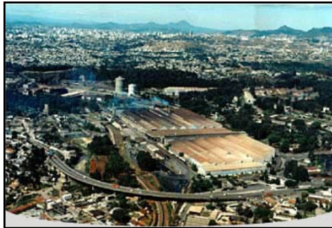
Figura 1: Usina Siderúrgica Integrada de Barreiro.
