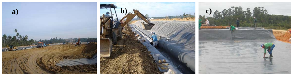
Figura 2: Obras de implantação do aterro SANTEC Resíduos. a) Camada de proteção mecânica sobre a manta de PEAD; b) Instalação do dreno principal do chorume; c) Colocação Manta PEAD com 2 mm de espessura.
